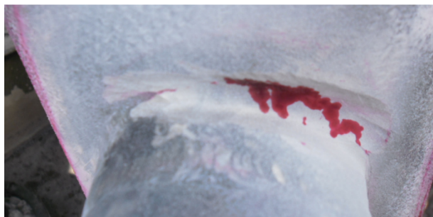
Рис. 2. Трещина по периметру сварного шва (увеличено) приварки муфты пигтейля трубы № 14
